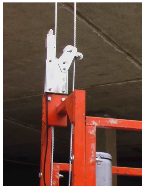
Рисунок 7 – Сборка консолей фасадного подъемника
